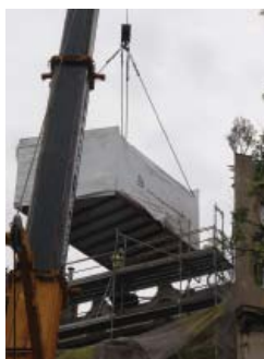
4. FINALITZACIÓ DEL PROCÉS D'HISSAT EN EL MOMENT DE DIPOSITAR EL MÒDUL A LA TERRASSA
