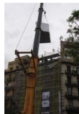
3. PROCÉS D'HISSAT. L'ALTURA MÀXIMA DEL BRAÇ DE LA PLOMA ÉS DE 70 M, LA DE L'EDIFICI DE 20 M
