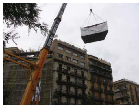
3. PROCÉS D'HISSAT. L'ALTURA MÀXIMA DEL BRAÇ DE LA PLOMA ÉS DE 70 M, LA DE L'EDIFICI DE 20 M
