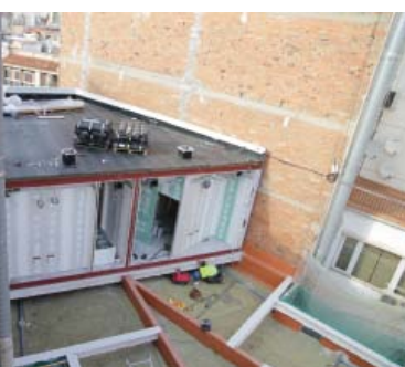
5. VISTA SUPERIOR DE L'ANTIGA TERRASSA CONVERTIDA EN LA PLANTA DE L'ÀTIC ON S'APRECIIEN LES BIGUES DE SUPORT I MÒDULS JA INSTAL·LATS, D'ESTRUCTURA D'ACER
